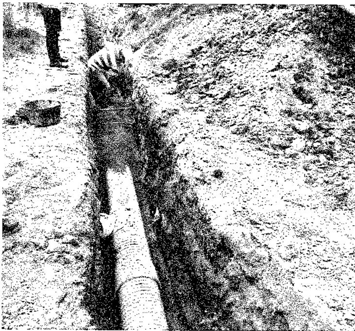
**Relleno en arena para asentar tubería.**
