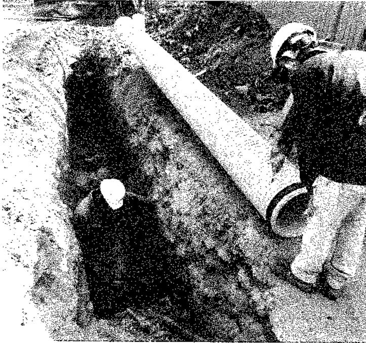
**Tubería Novaforf 16" para red de alcantarillado sanitario.**
