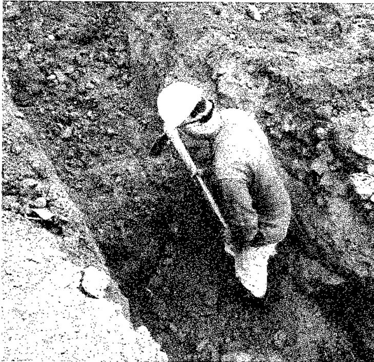
**Excavación manual en material común.**
