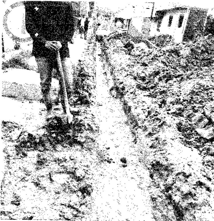
*Registro 1. Excavación en material común y suministro e instalación de tubería de red de acueducto.*
