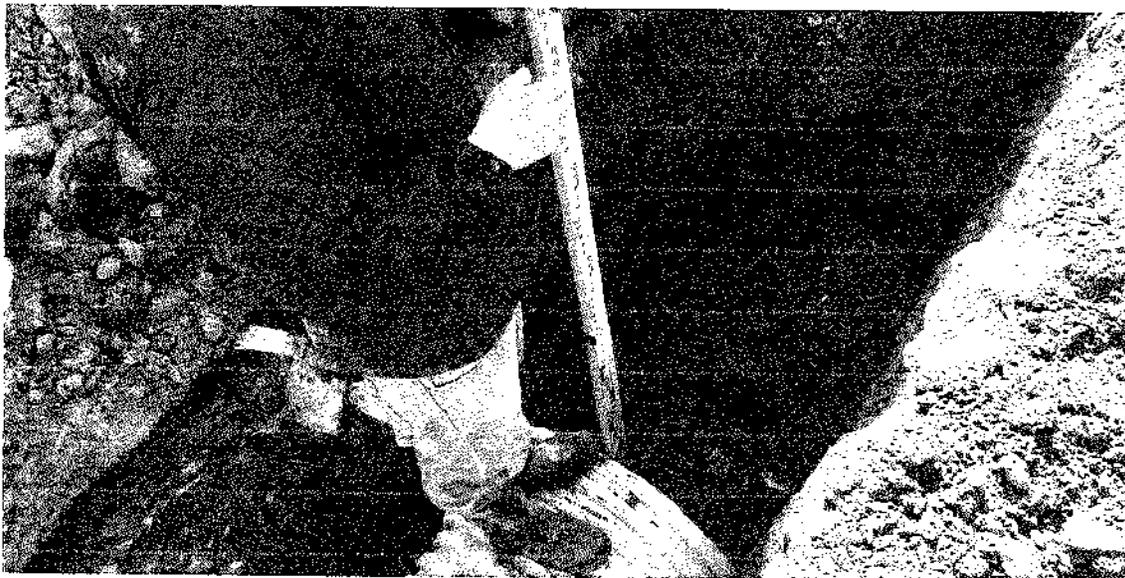
Registro 4. Suministro e instalación de tubería para red de alcantarillado de 24".
